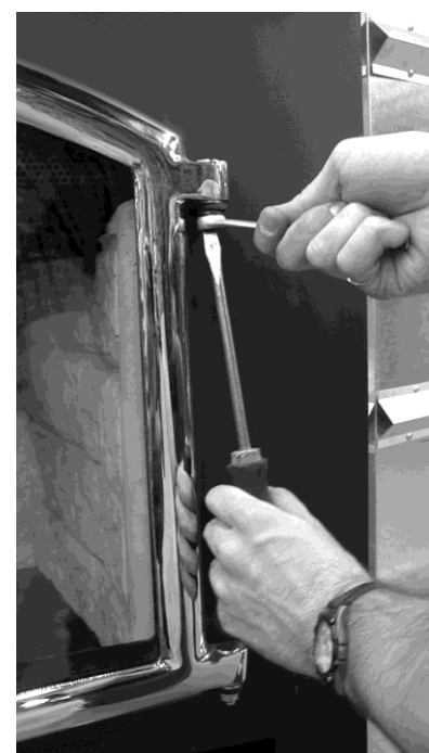
Figure 6 Ajustement des pentures de porte
